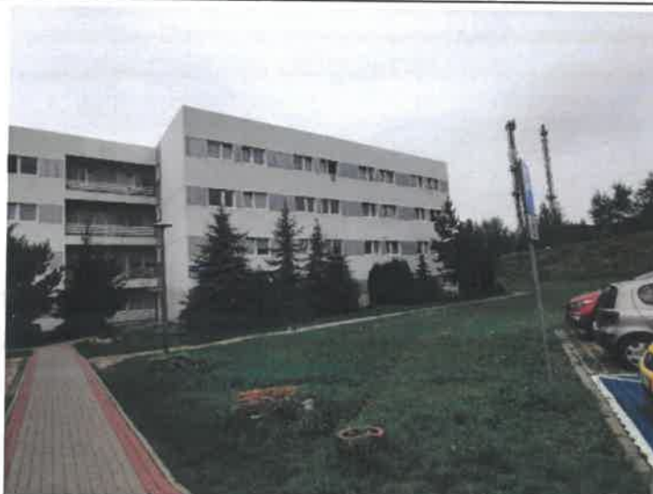
Budynek przy Alei Zwycięstwa 91 – widok zewnętrzny
